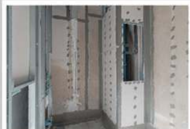
รูปตัวอย่างการติดตั้ง Smartboard ในห้องน้ำ
